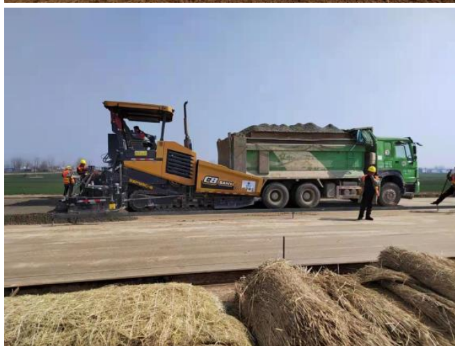
现场施工景象
