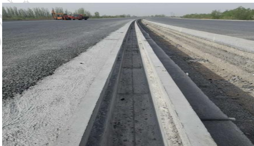
图 6 纵向排水沟施工效果
