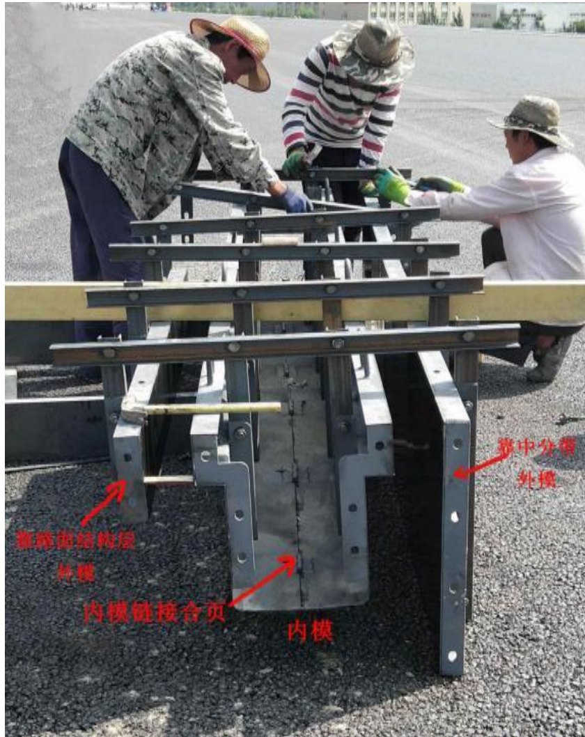
图3 整体性纵向排水沟钢模板横截面图
