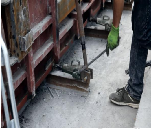
图 4 用小千斤顶稳固模板下口
