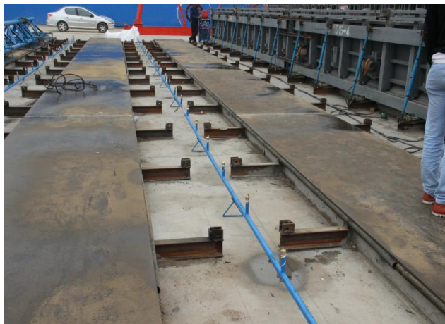
图 2 预埋构件实物图
