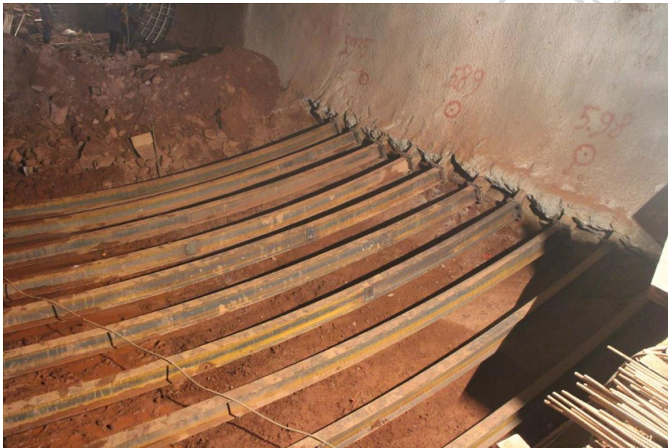
仰拱钢拱架连接效果
