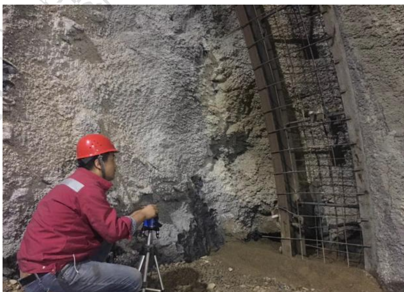
拱架安装激光水平仪定位
