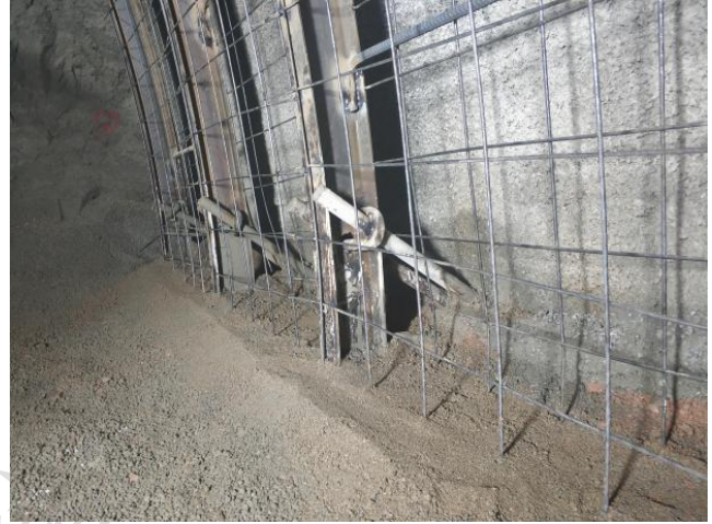
铺设掩埋保护拱架连接板
