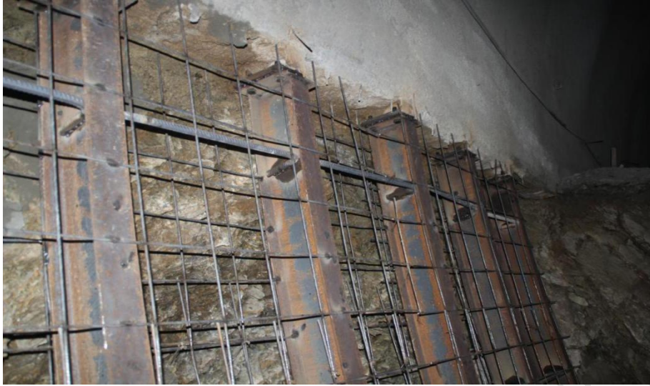
上下导拱架连接效果图
