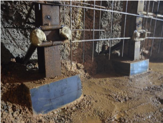
钢板砂箱拱架连接板支垫
