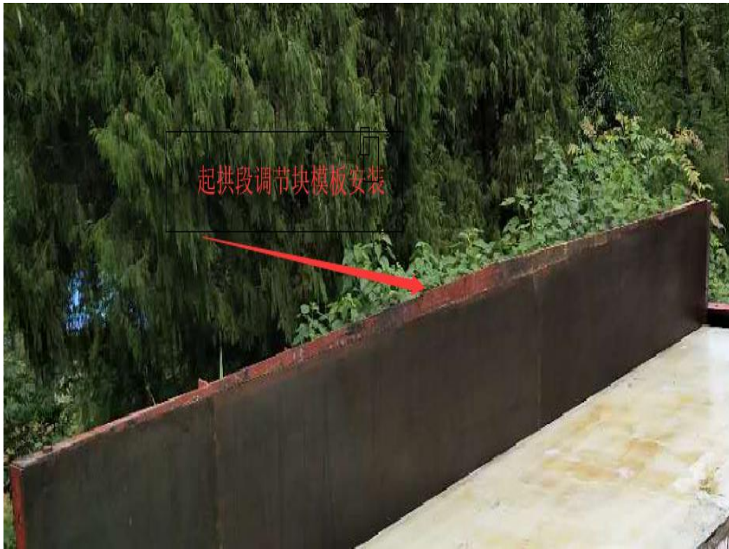
图 5 起拱调节块安装图
