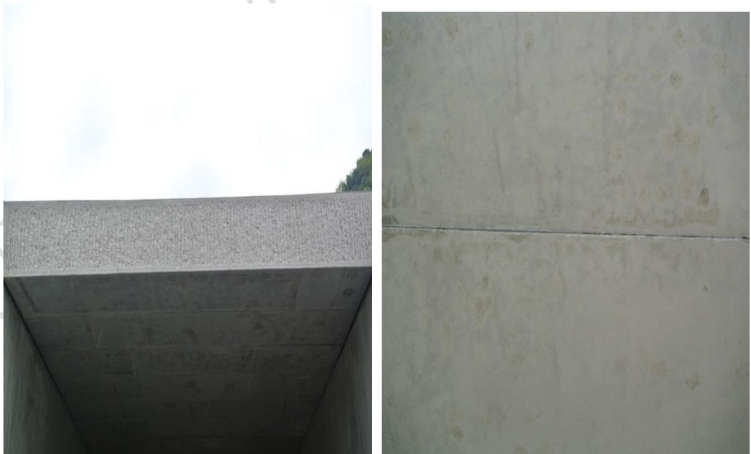
图 2 安装过程中的涵洞盖板
