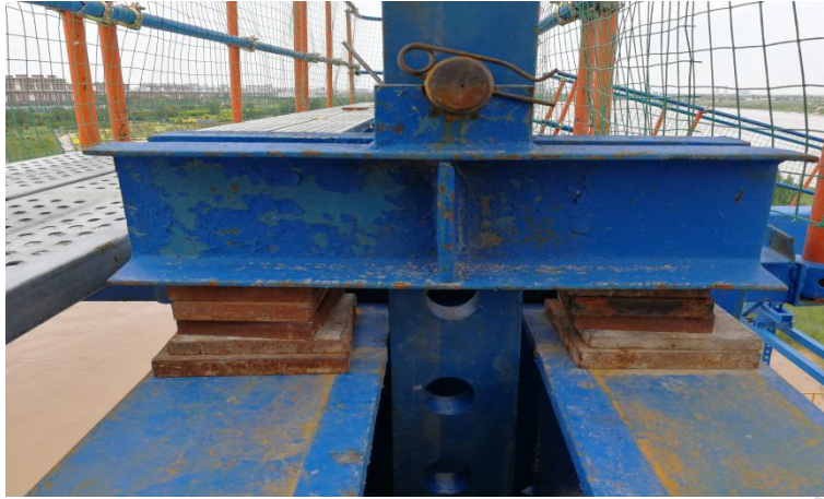
图 7 传统的挂篮吊带标高调整示意图
