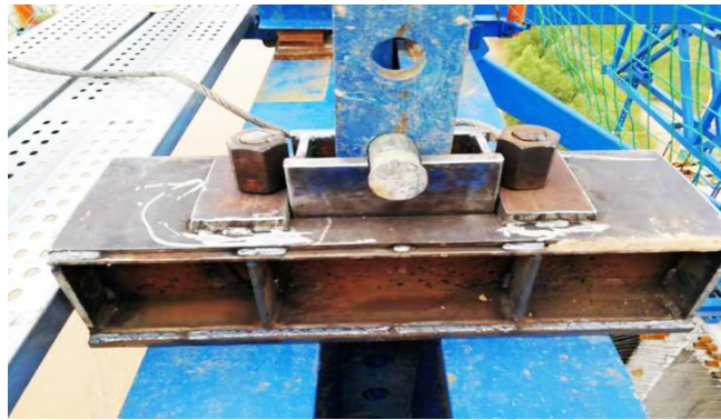
图 1 挂篮吊带调节器整体效果图
