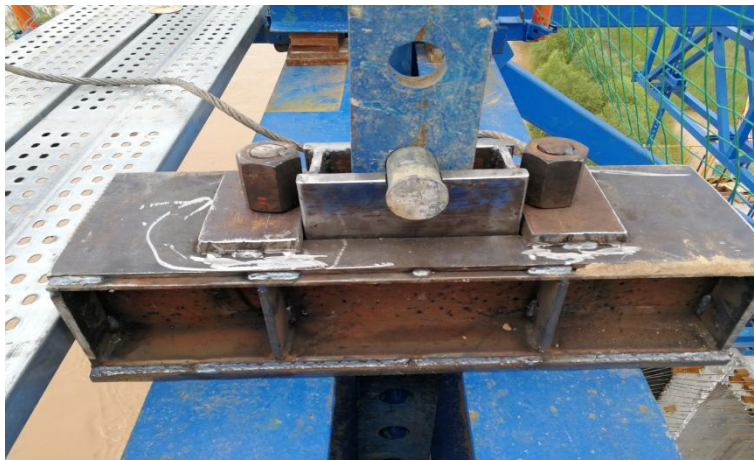
图 8 新型挂篮吊带调节器示意图
