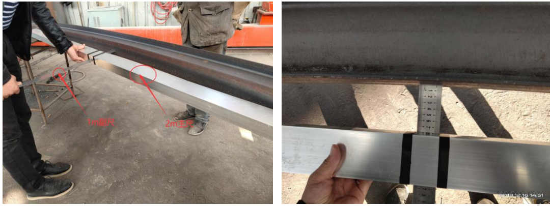
图 5 拱架弧形量测扣尺现场使用图
