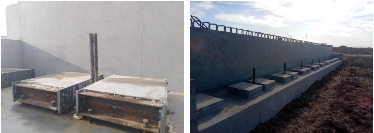
图 2 套箱式支座垫石模板应用效果照片
