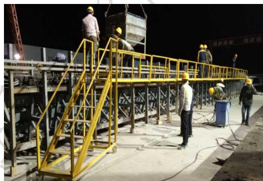
图 2-2 拼装好后的悬挂式安全平台
