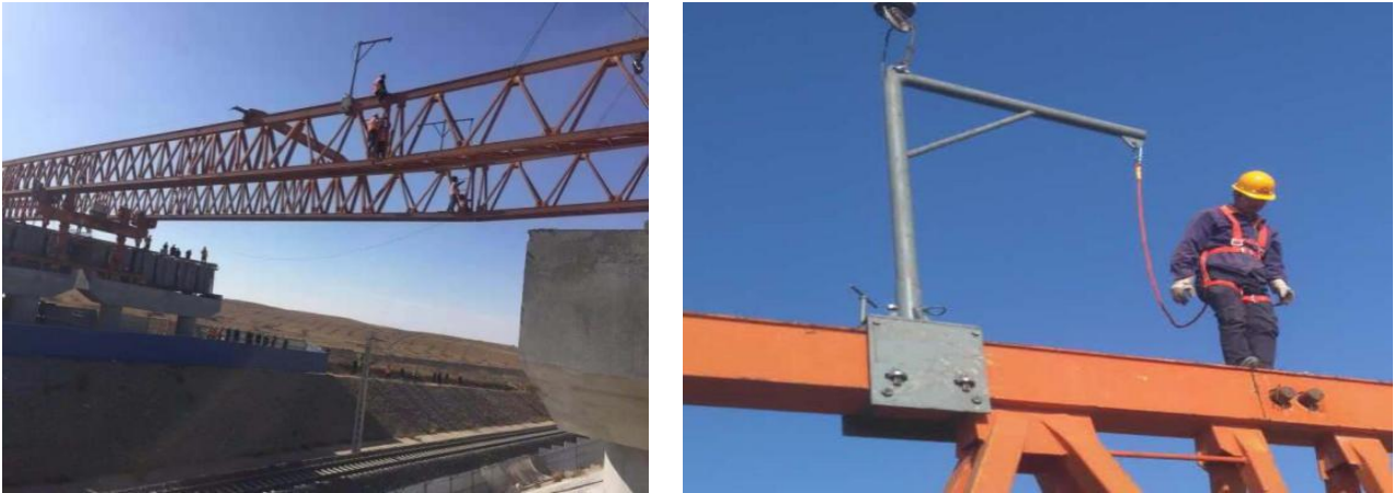
图 3 利用防坠机进行架桥机主梁拆除作业图片
