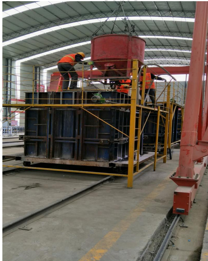
图9 在移动式台座上浇筑混凝土
