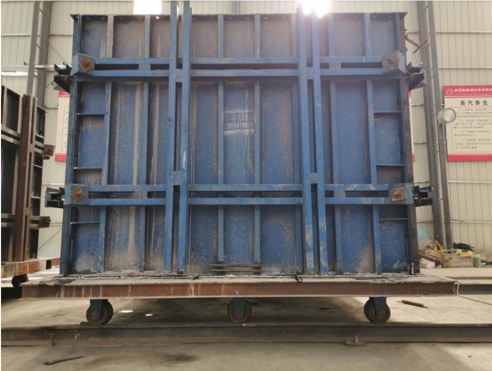
图8 在移动式台座上安装模板
