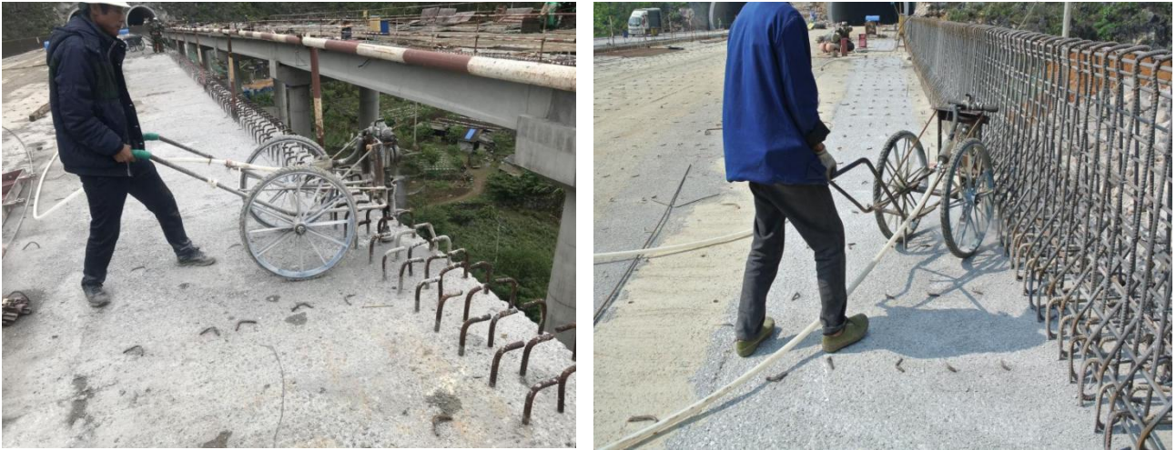
图 13 护栏底座凿毛处理
