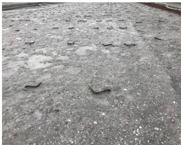
图 8 凿毛清洗后的效果
