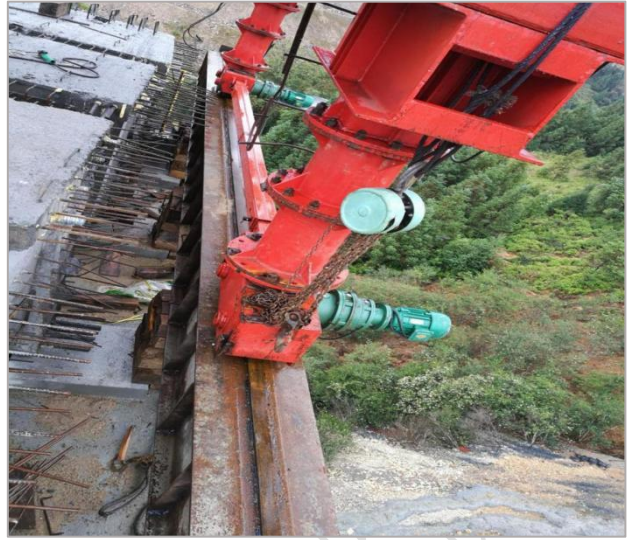
图 6 前支腿横移轨道加宽改造 2
