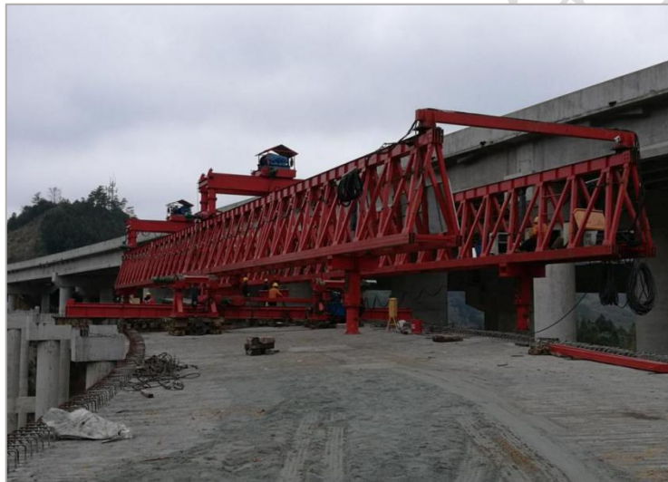
图 7 纵导梁缩短改造后整机
