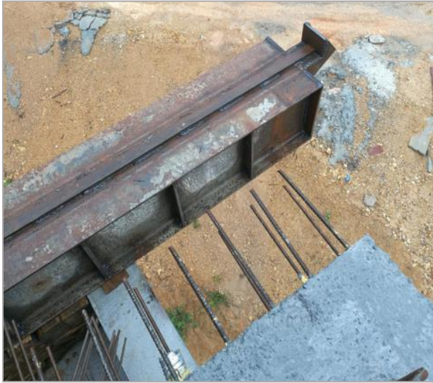
图 5 前支腿横移轨道加宽改造 1
