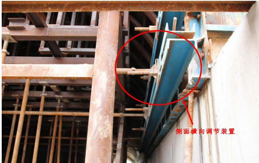
图 4 侧面横向调节装置
