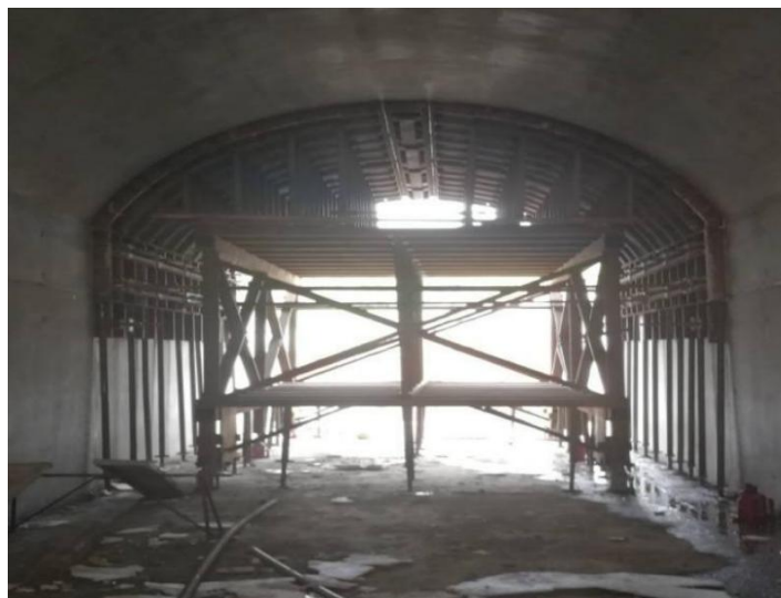
图 1 拱涵三向调节移动模架整体效果图
