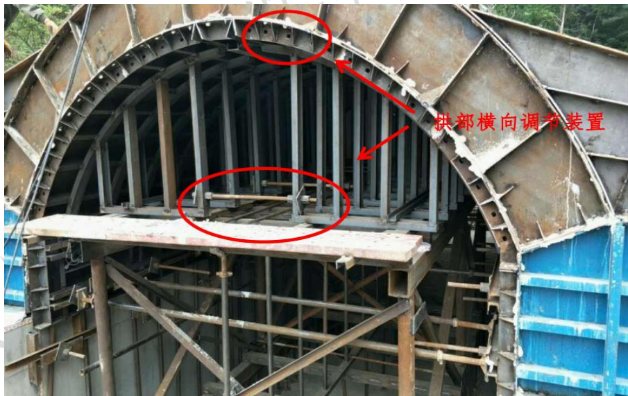
图 3 拱部横向调节装置
