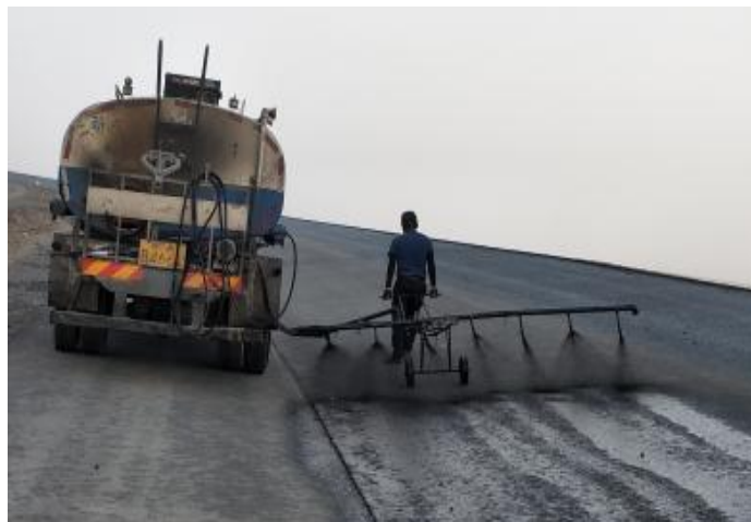
图 6.2.3 超大斜面沥青路面粘层洒布
