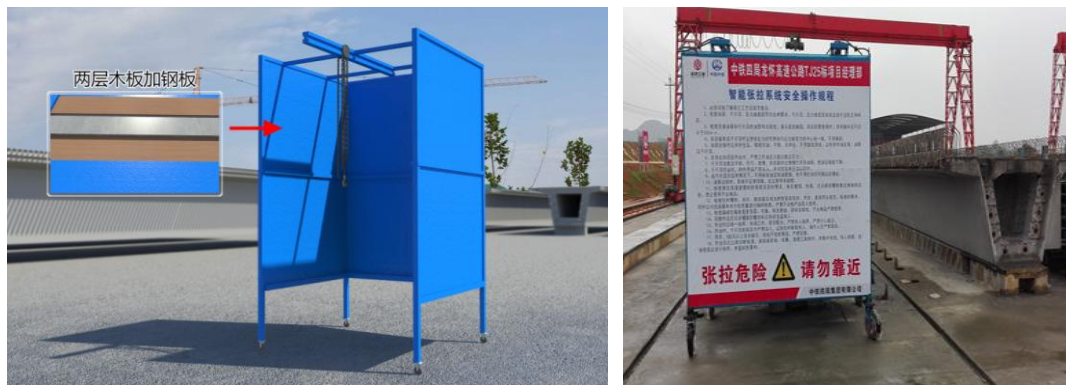
图 8-4 智能张拉压浆隔离防护挡板实景图
